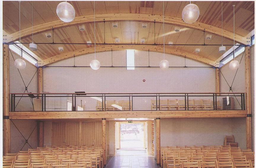
Takflatene og takkonstruksjonen med de bærende søylene samt oppbygningen av galleriet er en trekonstruksjon i kontrast til veggflatene for øvrig og er konstruktivt fristillet fra murveggene.
